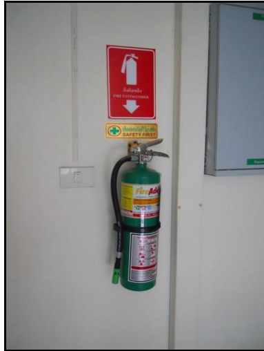
ภาพที่ 6-36 ถังดับเพลิง
