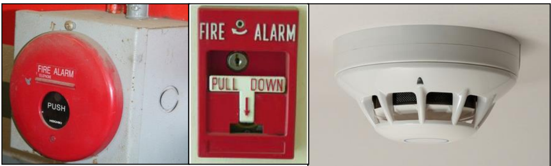
ภาพที่ 6-34 สัญญาณเตือนภัยแบบต่างๆ ได้แก่ สัญญาณเตือนภัย (Fire Alarm) และเครื่องตรวจจับควัน (Smoke Detector) ตามลำดับ
