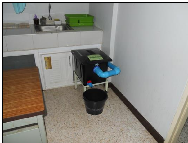
ภาพที่ 5-25 การติดตั้งถังดักไขมันสำเร็จรูปบริเวณพื้นที่ล้างภาชนะ อาคารเรียนรวม 14 มหาวิทยาลัยราชภัฏกำแพงเพชร
