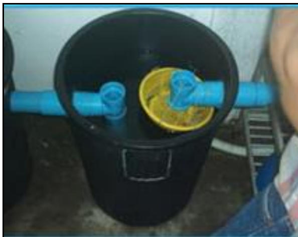
ภาพที่ 5-26 บ่อดักไขมันประดิษฐ์อย่างง่าย
