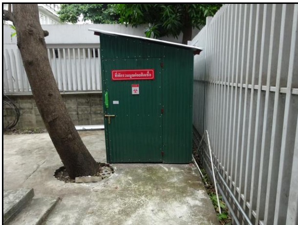
ภาพที่ 5-22 ที่พักขยะมูลฝอยติดเขื่อนก่อนส่งกำจัดของอาคาร 576 สหคลินิกการไฟฟ้านครหลวง
