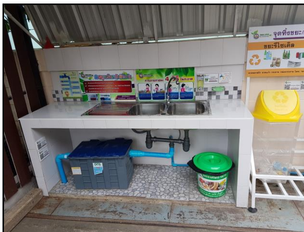
ภาพที่ 5-24 การติดตั้งถังดักไขมันสำเร็จรูปบริเวณพื้นที่ล้างภาชนะ การไฟฟ้าส่วนภูมิภาคจังหวัดปทุมธานี
