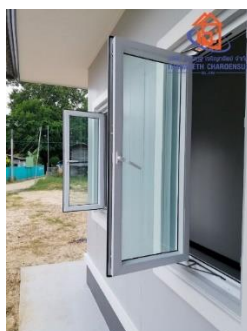
ภาพที่ 1 ตัวอย่างหน้าต่างที่ใช้กระจกเทมเปอร์และกรอบหน้าต่างที่ใช้วัสดุ UPVC ที่มา: https://baanubonupvc.com/
